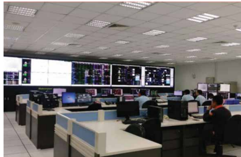
Trung tâm điều độ và quản lý các loại năng lượng điện, khí nhiên liệu, hơi nước, nước...của xường Gang thép Hà Tĩnh.
