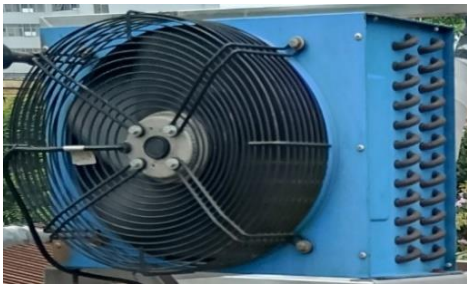
Hình 4. Hình ảnh thiết bị ngưng tụ thực tế
