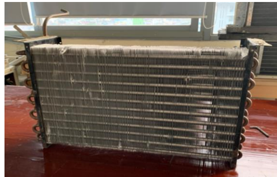
Hình 6. Hình ảnh thiết bị bay hơi thực tế
