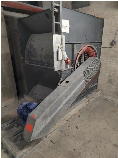
Hình 8 Ví dụ về quạt thông gió điều khiển bằng dây đai.
