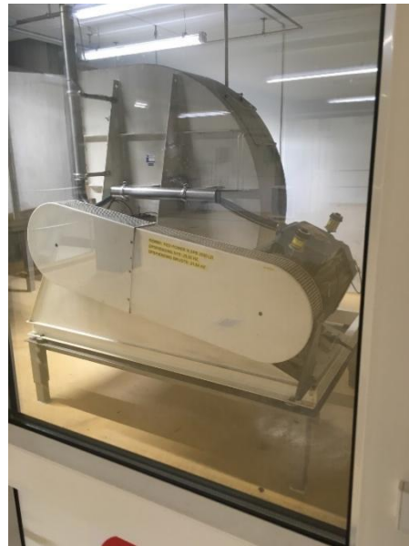
Hình 8 Ví dụ về quạt thông gió điều khiển bằng dây đai.
